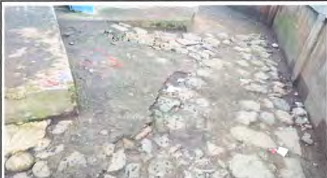
Foto 7: PISO DE CONCRETO. Sustrucción de empedrado existente deteriorado por lluvia, por fundición de piso de concreto de 0.10 m. de espesor. Empedrado en mal estado.
