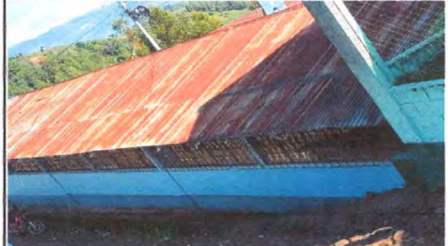
Foto 2: MODULO DE AULAS. Sustitución de lámina existente por lámina troquelada de Aluzinc, calibre 26 Maxalum colocación de canal metálico y colocación de bajadas de agua pluvial de tubo PVC de 80 PSI x 3"
