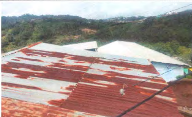
Foto 3: ANEXO LAB. DE COMPUTACION. Sustitución de lámina existente por lámina troquelada de Aluzinc, calibre 26 Maxalum, colocación de canal metálico, colocación de bajadas de agua pluvial de tubo PVC de 80 PSI x 3"
