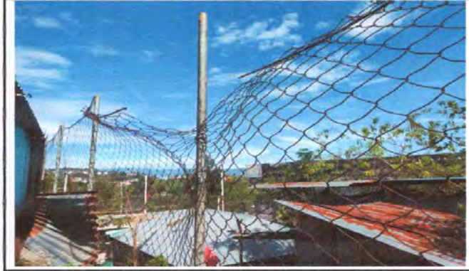
Foto 4: MURO PERIMETRAL. Sustitución de perímetro de malla galvanizada AG calibre 12.
