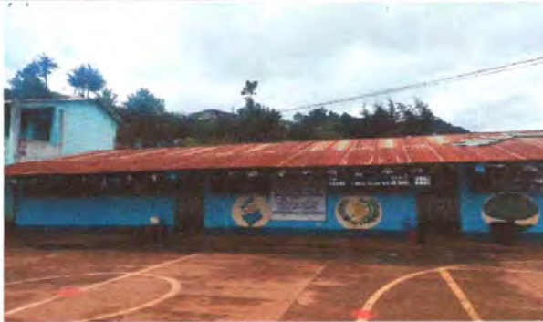
Foto 1: MODULO DE AULAS. Sustitución de lámina existente por lámina troquelada de Aluzinc, calibre 26 Maxalum, colocación de canal metálico y colocación de bajadas de agua pluvial de tubo PVC de 80 PSI x 3"
